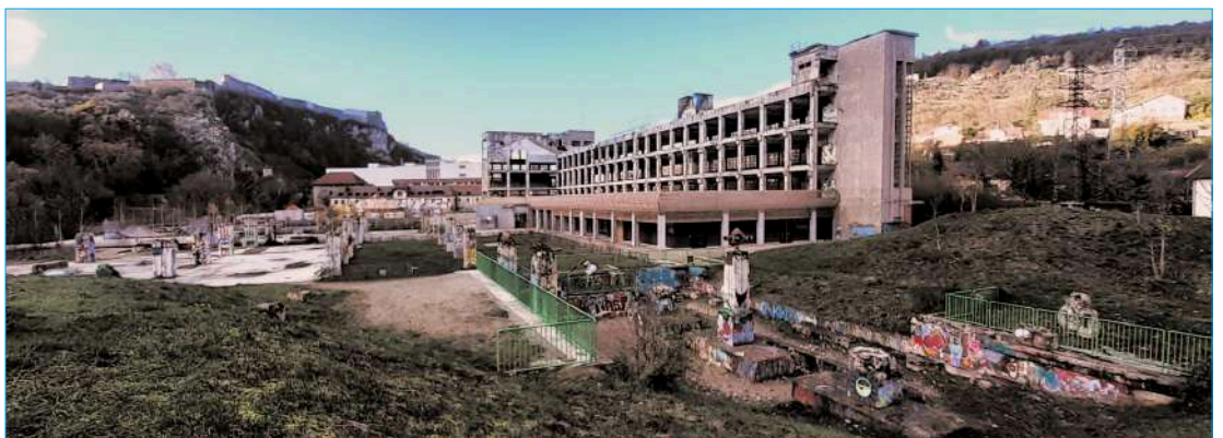
Vue générale du site industriel de la Rodiacéta. La base nautique est logée au rez de chaussée de ce qu'il reste du bâtiment appelé la Cathédrale. La vocation des étages n'est pas encore définie. Le Doubs coule à gauche de l'image au pied de la colline où se trouve la Citadelle. © Michel Chapuis
